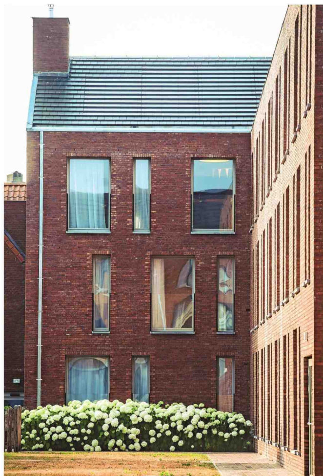
Zonnepanelen mogen in Brugge niet zichtbaar zijn vanop straat, zelfs als je ze bijna niet kunt zien. Bij Ter Potterie vind je de panelen dan ook op het dak aan de kant van de binnentuin. Foto Benny Proot
